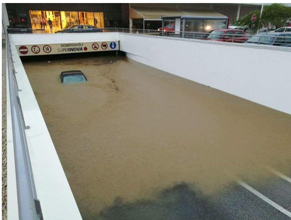
Slika 3 Poplavljena garaža trgovačkog centra
