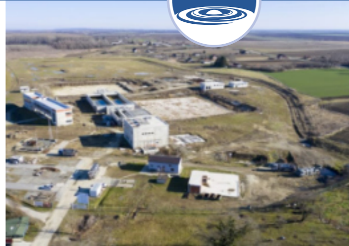
Fotografija preuzeta s: https://vodovod.com/2021/10/15/potpisivanje-ugovora-o-izvođenju-radova-postrajenje-za-prociscavanje-otpadnih-voda-grada-osijeka-16-srpnja-2021/
