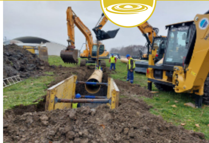
Fotografija preuzeta s: https://djurdjevac.hr/gradska-uprava/zapoceli-radovi-na-aglomeraciji-durdevac/
