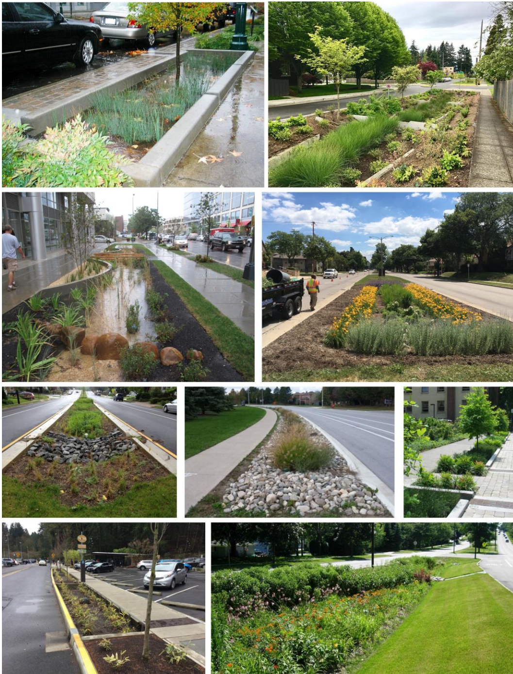
Slika 4.8.9. Primjer izgrađenih bioretencija uz prometnice (preuzeto iz različitih Internet izvora).
