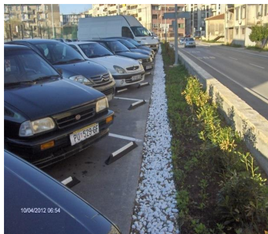
Slika 4.9.5. Infiltracijski jarci parkirališta Dom Braće Ribar Pula
