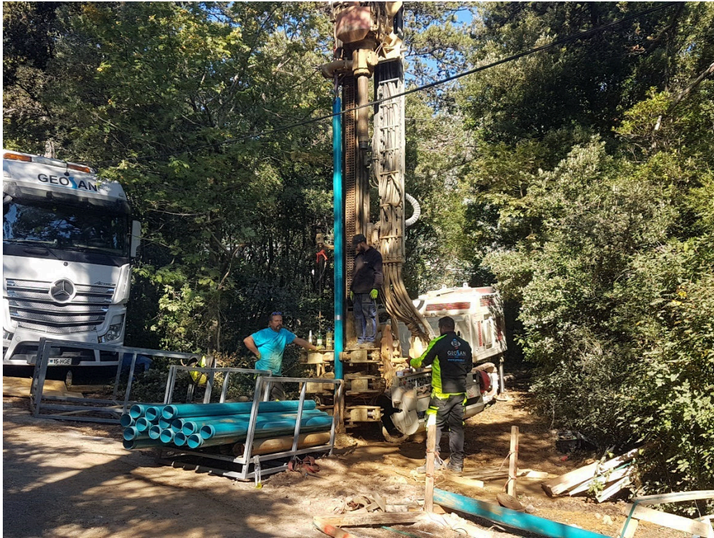
Slika 13. Izvedba piezometra Martinščica
