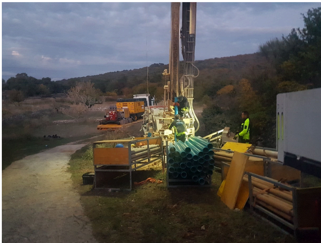
Slika 10. Izvedba piezometra Valun
