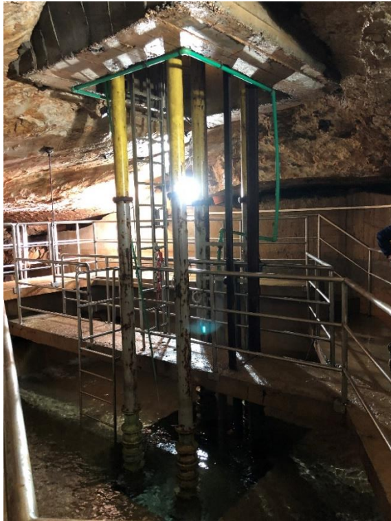
Slika 2.4.5. Izvorište Tunel Učka dne 19.7.2019. – podzemna kaptaza (lijevo) i dotok vode preko Thompsonovog preljeva (desno)
