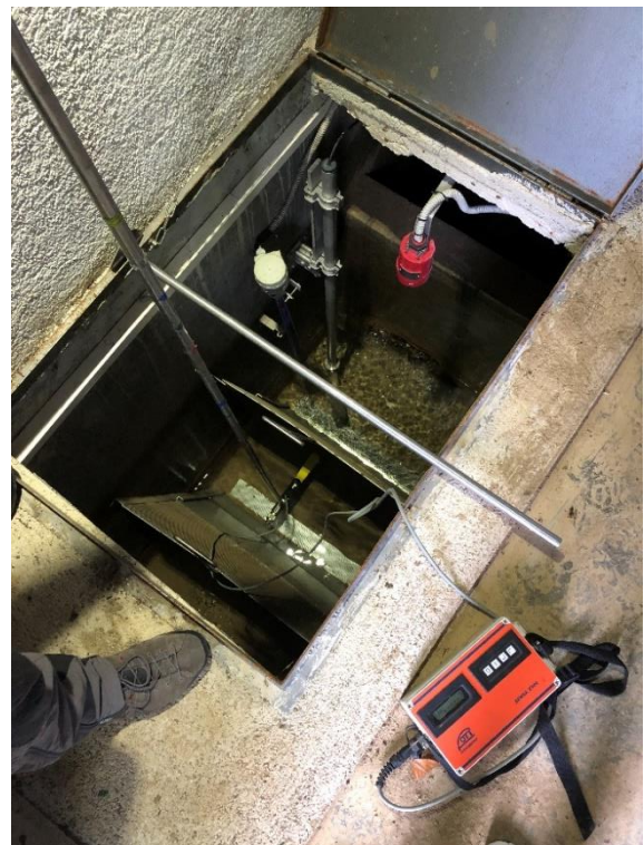
Slika 2.4.4. Izvor Rečina dne 19.7.2019. – kaptaza (lijevo) i mjerenja protoka unutar kaptaze (desno)
