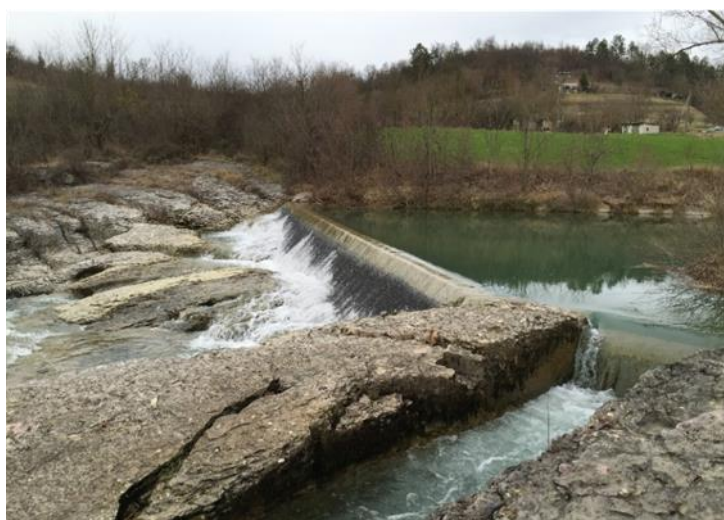
Slika 3.3.14. Pozicija 5 – Betonska pregrada u koritu Pazinčice koja je usmjeravala vodu na Tomažinov mlin
