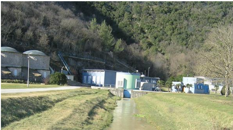
Slika 2.2.8. Pogled na preljevni kanal izvorišta Rakonek (lijevo) i crni bazen u kome je postavljen limnigraf (desno)
