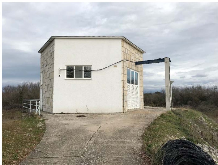
Slika 2.3-1. Zdenac B-4 na vodocrpilištu Bokanjac
