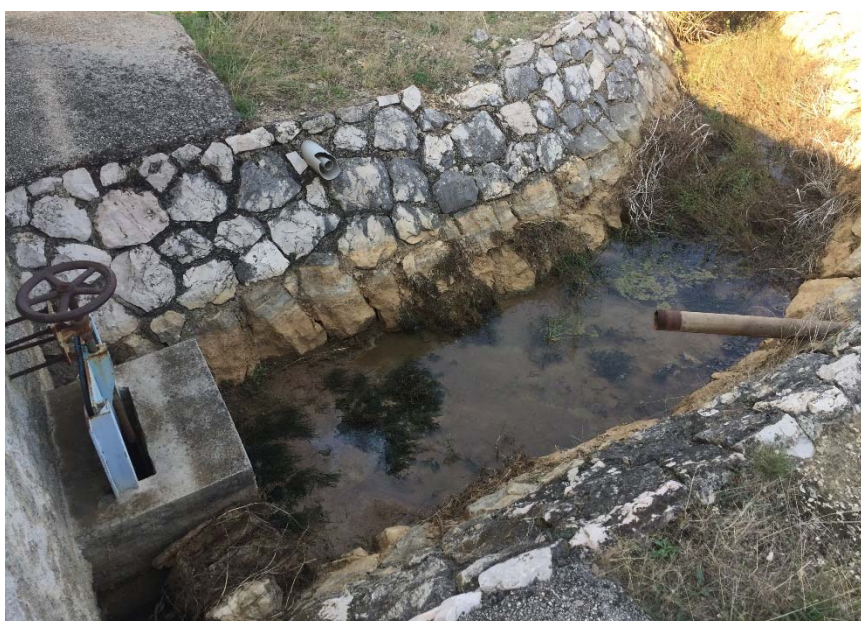
Slika 5.2-5. Odvodni kanal za izvoru Oko gdje su vršena mjerenja protoka (situacija 29.8.2018.)
