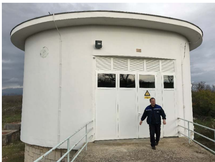
Slika 2.3-2. Zdenac B-5 na vodocrpilištu Bokanjac
