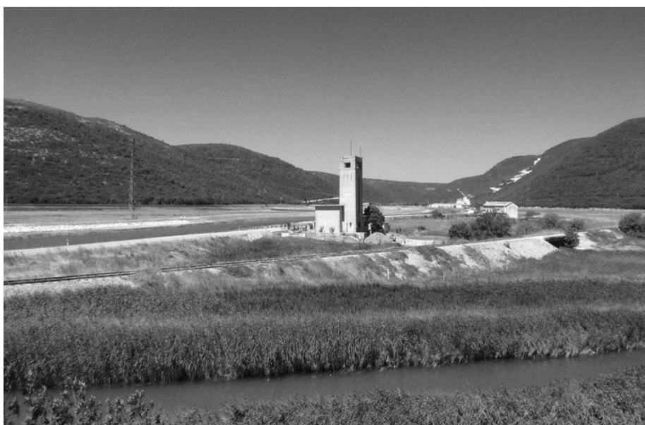
Slika 5. Crpna stanica na rijeci Raši (preuzeto sa Google Earth-a, pogled s kanala Krapanj)
