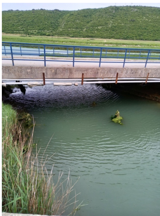
Slika 12. Kanal Krapanj (fotografija sa željezničkog mosta 04.05.2021.)
