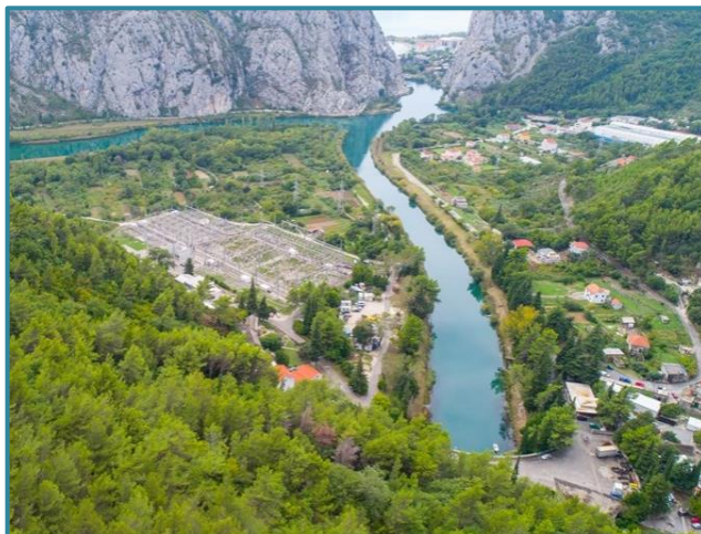
Slika 72: Postrojenje HE Zakučac
