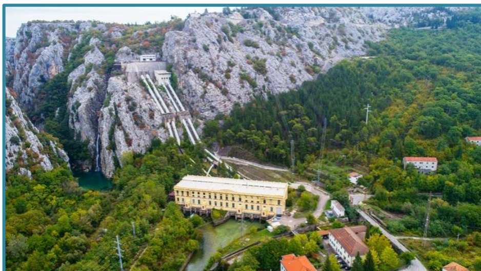
Slika 81: Postrojenje HE Kraljevac
