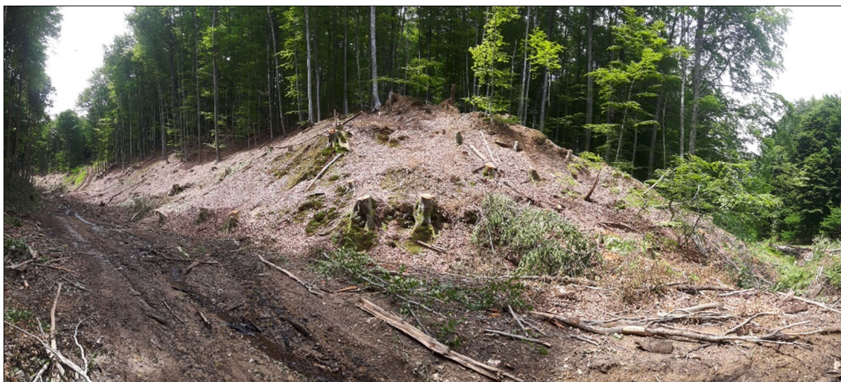
Slika 6-18 Šumski putevi na Petrovoj gori erodirani strojnim izvlačenjem trupaca
