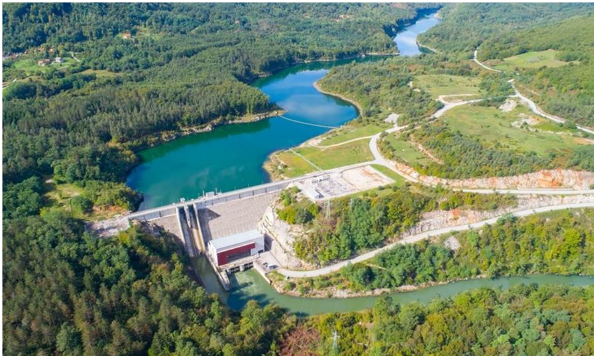
Slika 6-8 Hidroelektrana Lešće s pripadajućom akumulacijom (Foto: HEP proizvodnja)
