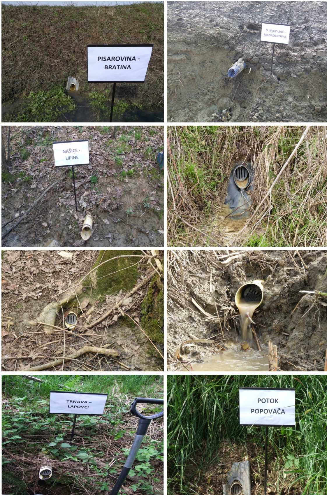
Slika 9. Fotografski prikazi kao primjeri dobro očuvanog i/ili obnovljenog hidromelioracijskog sustava podzemne odvodnje-cijevne drenaže (2017-2019)
