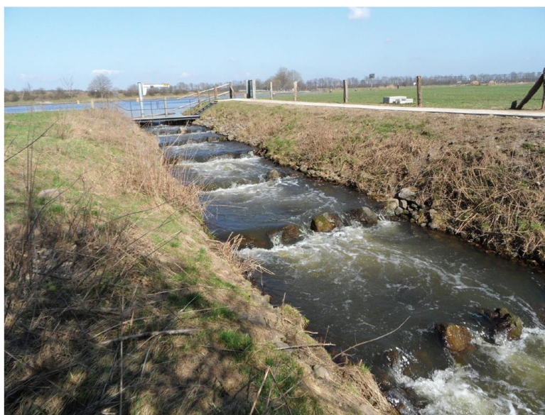
Slika 4.11. Primjer prirodne riblje staze s pragovima od velikih kamenih blokova (PIANC 2013)
