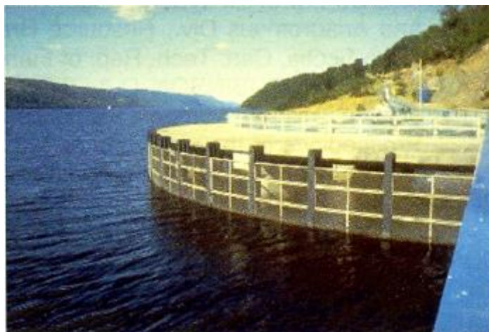
Slika 3.8. Primjer mrežaste pregrade na ulazu u turbinu (LARINIER and TRAVADE 2002)
