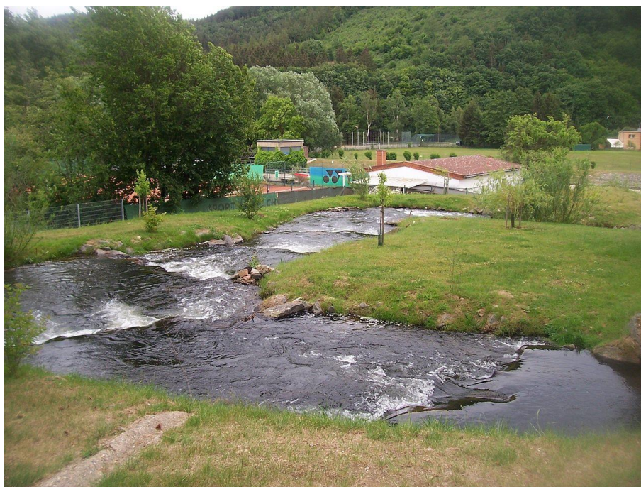
Slika 4.# Prirodna riblja staza – akumulacija Obermaubach, Njemačka ( https://commons.wikimedia.org/ )
