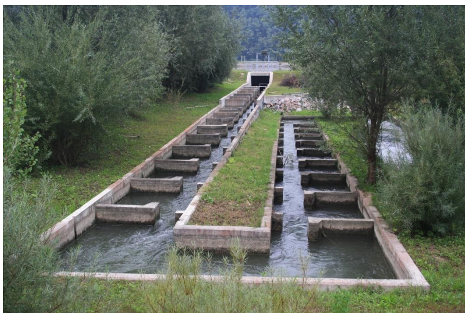
Slika 5.4 Riblja staza uz HE Blanca – SLO, r. Sava, staza s vertikalnim otvorima (svladavanje veće razlike u padu) prelazi u obilazni prirodni kanal
