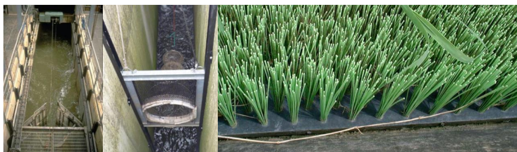
Slika 1.4. Lift za ribe (lijevo), riblja prevodnica (sredina)(PIANC 2013), čekinje u stazi za jegulje (desno) (EA 2010)
