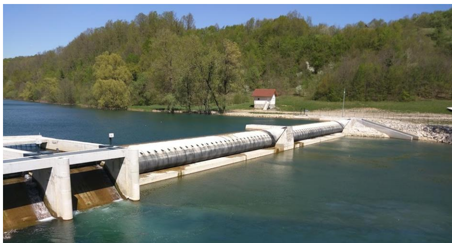
Slika 1.2 Pokretna brana za potrebe proizvodnje energije, mHE Ilovac
