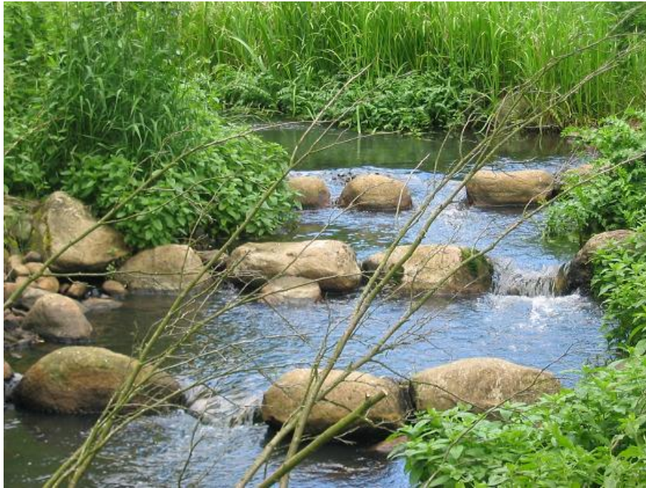
Slika 4.2c Riblja rampa Schlatbach, Njemačka ( https://commons.wikimedia.org/ )
