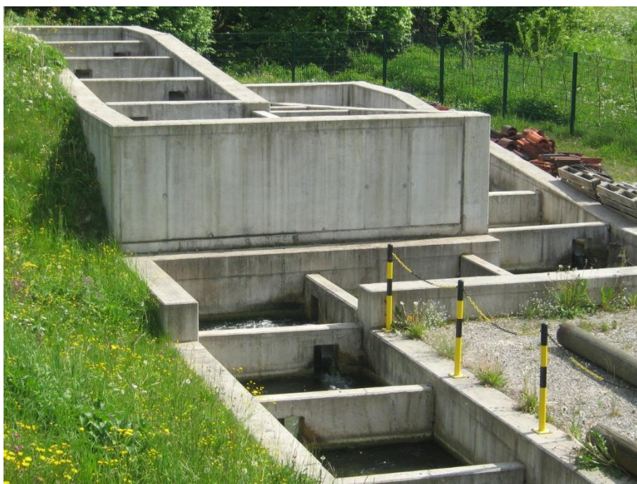
Slika 5.2 Riblja staza bazenskog tipa uz malu hidroelektranu u Njemačkoj
