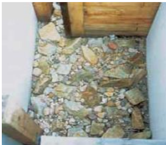
Slika 3.12. Dno riblje staze sa slojem grubog supstrata (FAO 2002)
