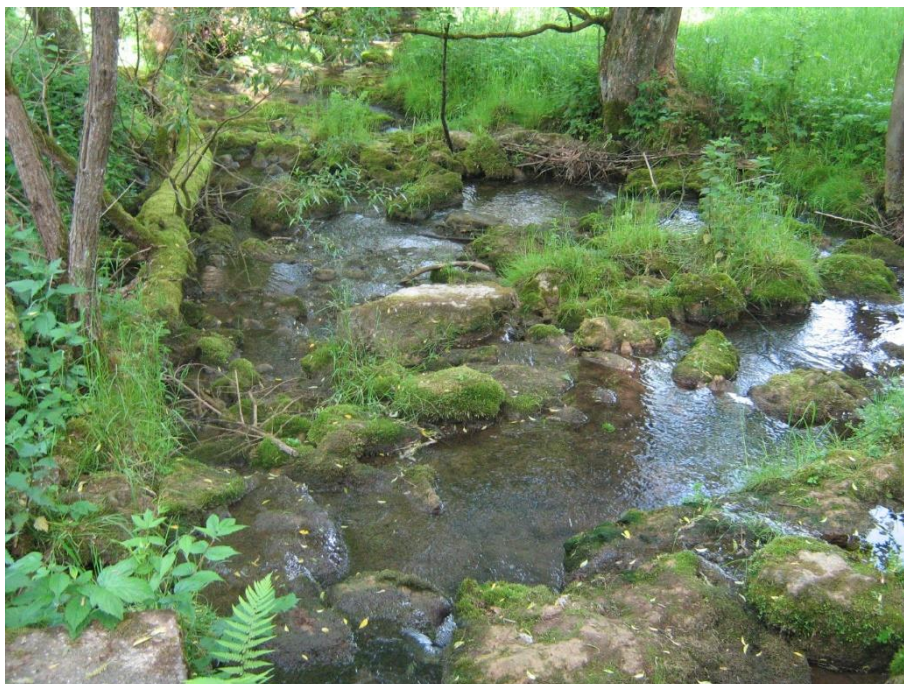
Slika 4.8 Riblja staza tipa obilazni prirodni tok u Bavarskoj
