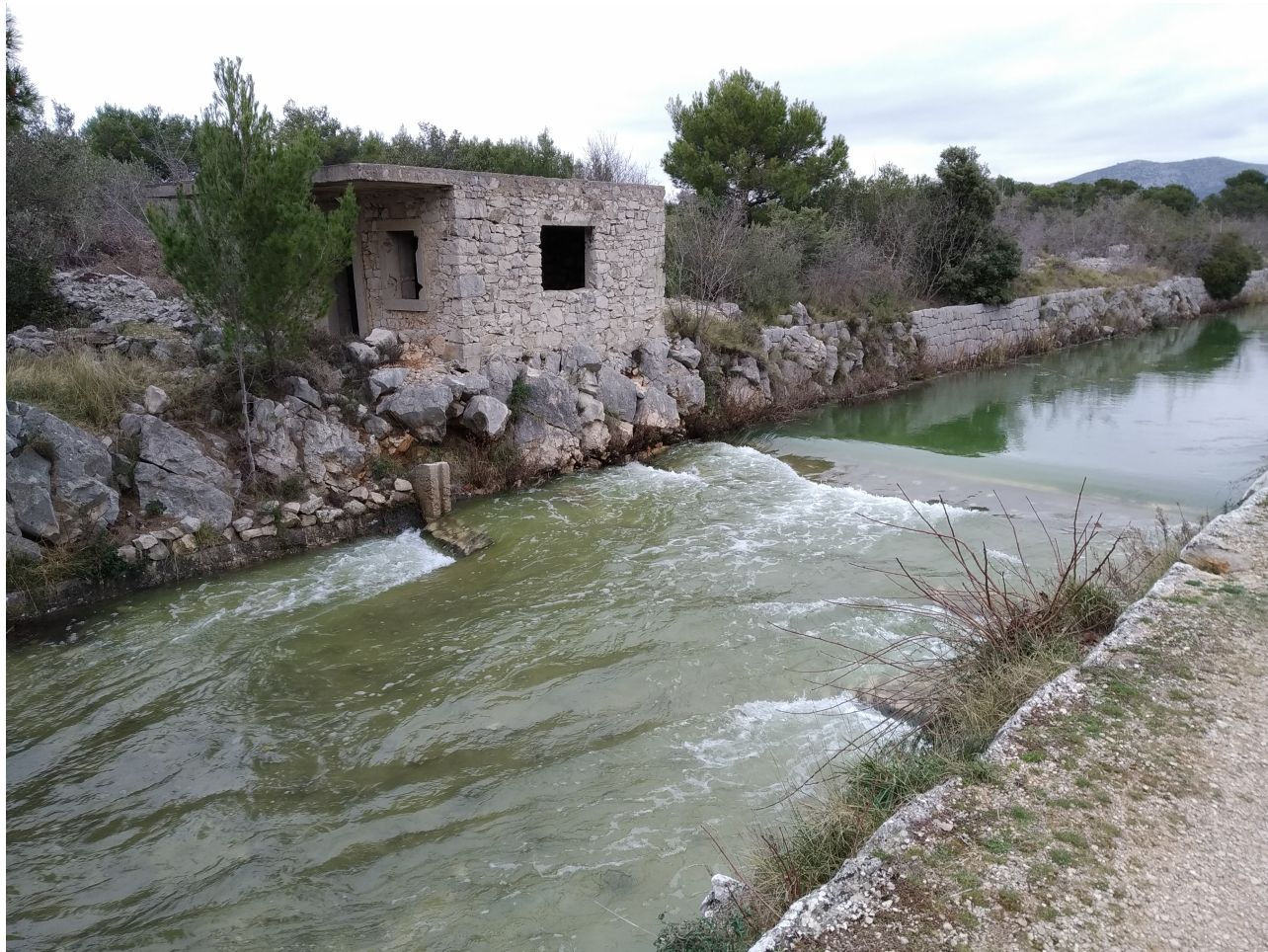
Slika 19: Preljevni prag s ribljom stazom na kanalu Prosika za vrijeme protoka vode kroz kanal (izvor: Hidromodeling d.o.o. 17.2.2021.)
