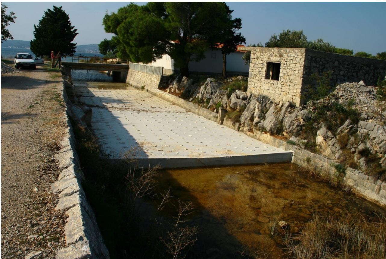
Slika 18: Preljevni prag s ribljom stazom na kanalu Prosika u suhom koritu (izvor: fotografija iz arhiva PP Vransko jezero)
