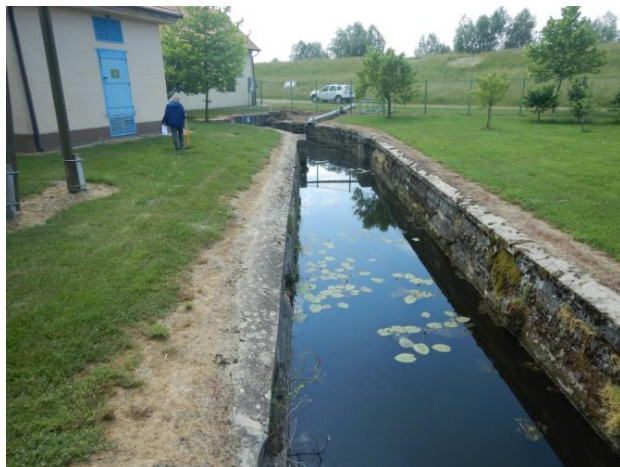
Slika 1.1a: Crpna stanica Podunavlje
