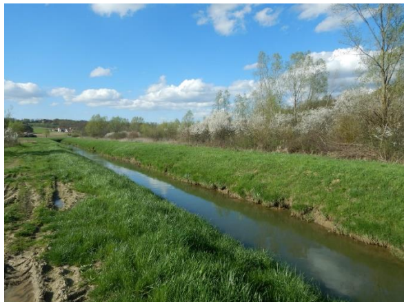
Slika 104.1a: Velika uzvodno od Poznanovca – uzvodno od dionice
