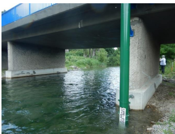
Slika 132.1d: Na građevini se ne vide tragovi erozije
