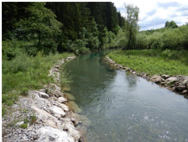
Slika 112.1b: Ribnjak prije utoka u Dobru – utvrđenost obala
