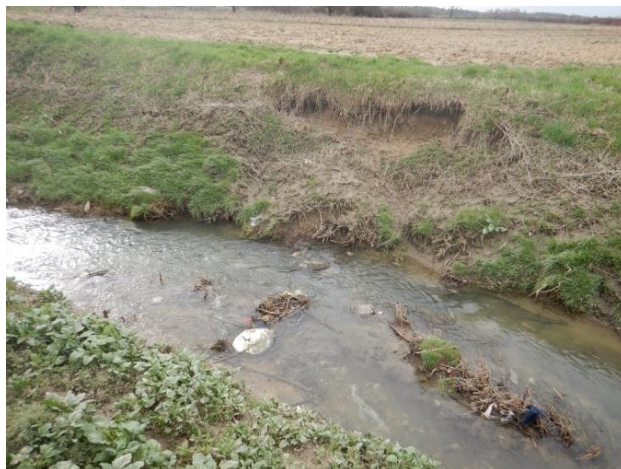
Slika 107.1b: Odranjavanje i erodiranje obale posljedica je kanaliziranja korita
