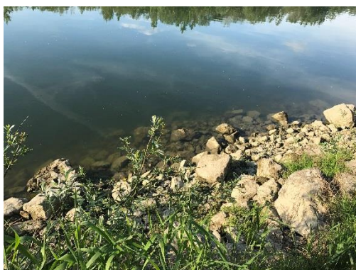
Slika 11.1c: - sediment/podloga, desna obala utvrđena kamenim nabačajem dok u koritu prevladava šljunak i pijesak
