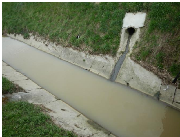
Slika 122.1b: Kanalizacijski ispust na istraživanom odsječku
