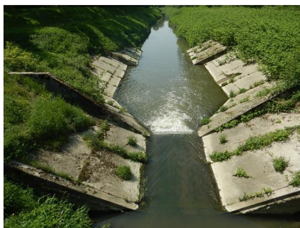
Slika 102.1d: Bjelovačka – preliv i utvrde
