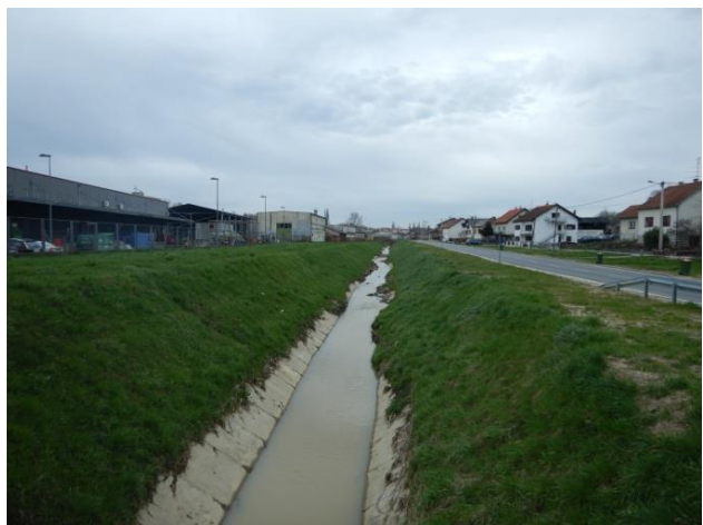
Slika 122.1a: Pogled na istraživani odsječak uzvodno
