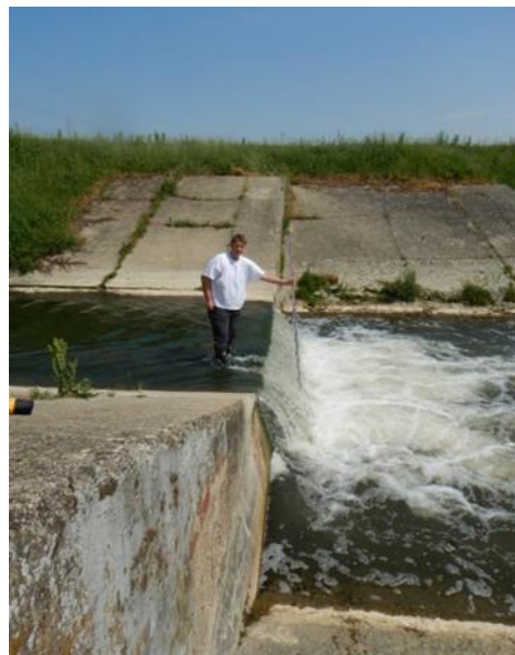
Slika 86.1b: Londža – preljevi i obaloutvrde
