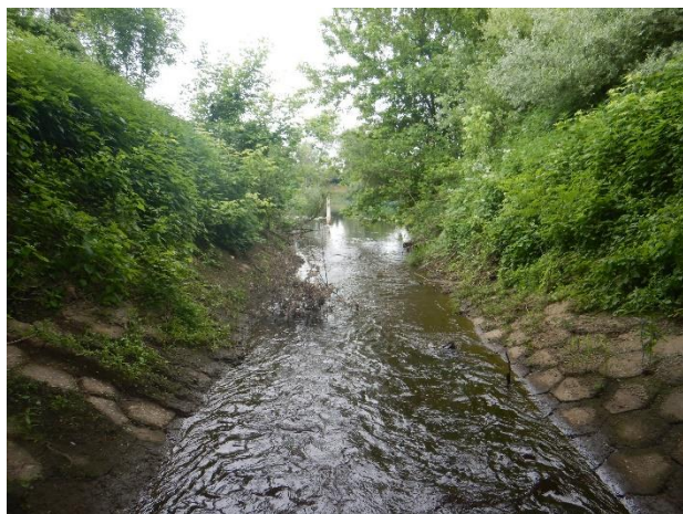
Slika 108.1c: Skopljak – utvrđenost obala
