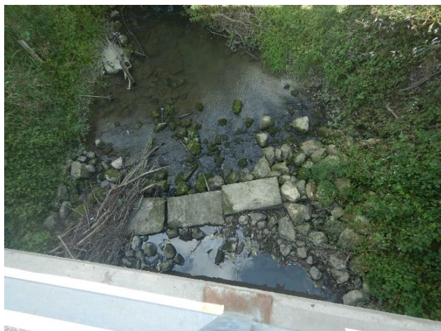
Slika 1c: Gliboki I - umjetni tvrdi materijali u koritu/prag
