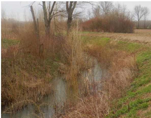
Slika 49.1a: Cuklin– uzvodno od dionice
