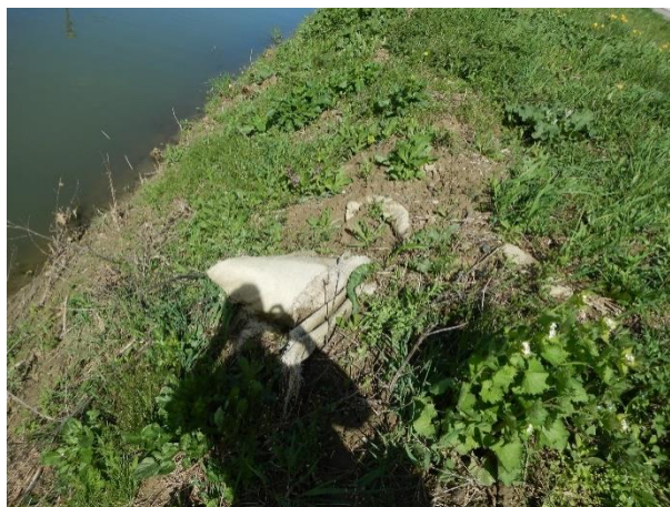
Slika 120.1b: Pinja – geotekstil u obali
