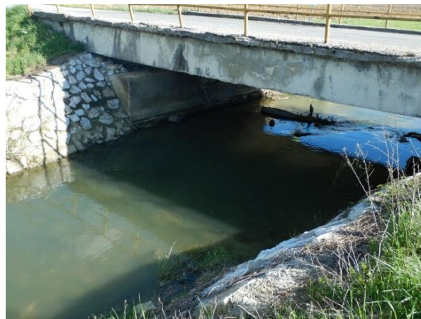
Slika 104.1d: Velika uzvodno od Poznanovca – nizvodno od dionice
