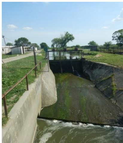
Slika 24.1a: Ustava za ribnjake na lokaciji monitoringa
