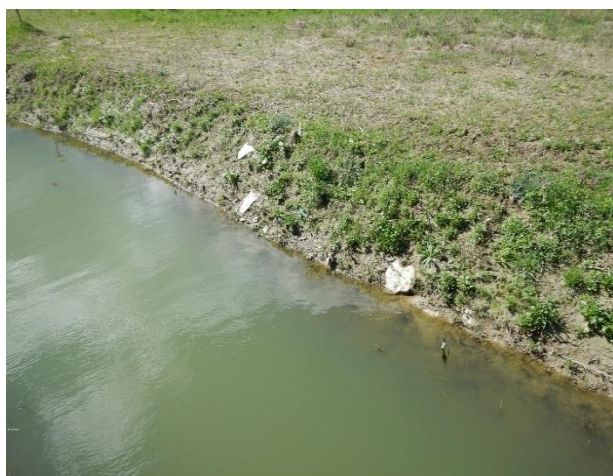
Slika 120.1c: Pinja – lijeva obala s ostacima kamenog nabačaja
