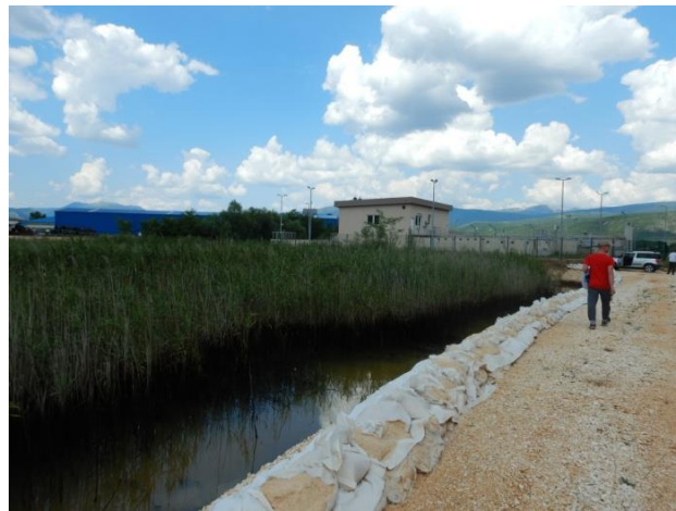
Slika 137.1b: Vreće pijeska na lokaciji na kojoj je nasip bazena nedavno puknuo
