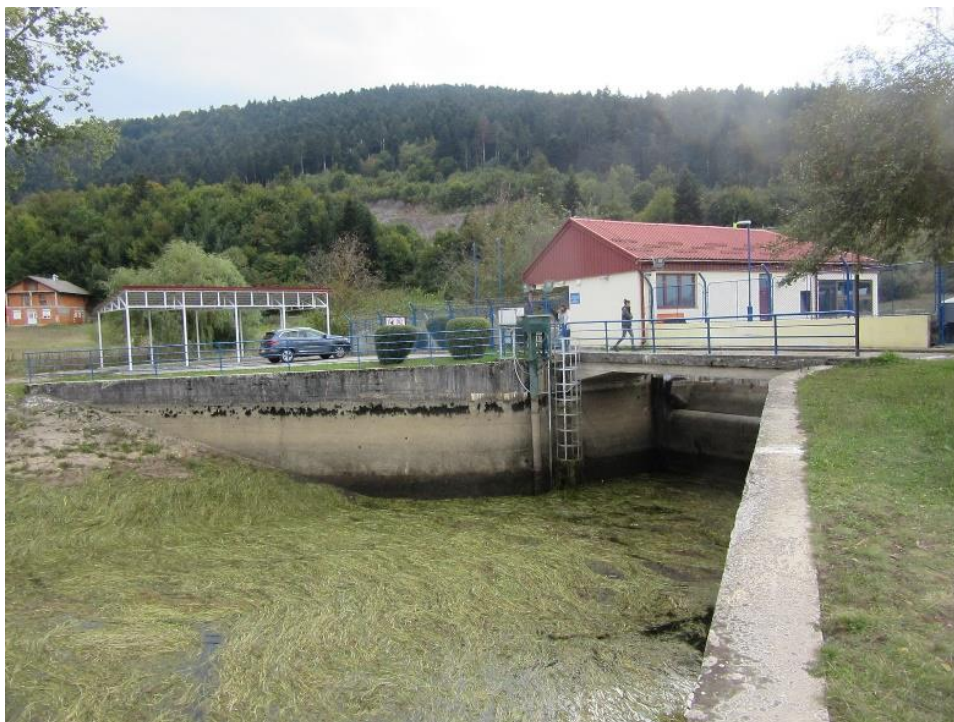
Slika 3.2.32. Čvorište Šumečica sa zapornicom prema nastavku Južnog kraka Gacke te hidrološkom postajom Šumečica
