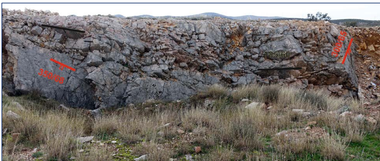
Fot. 6: Naslage gornje krede na južnom rubu područja Tvornice glinice. Vidljive su slojne plohe i dva sustava izraženih tektonskih pukotina. Sustavi slične orijentacije vrlo su česti na razmatranom području.
