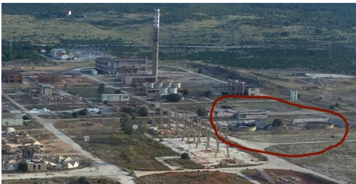
Fot. 1: Detalj područja tankvana prije nasipavanja. Čini se da u lijevom spremniku ima mazuta. Fotografiju iz vremena rušenja tvornice ustupio nam je g. Ivan Matić iz Ekološke udruge „Zrmanja“.
