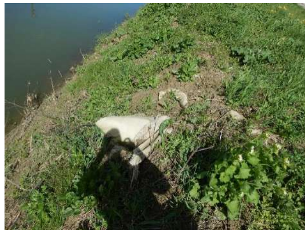
Slika 1b: Pinja – geotekstil u obali
