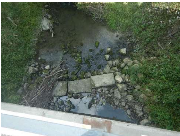
Slika 1c: Gliboki I - umjetni tvrdi materijali u koritu/prag
