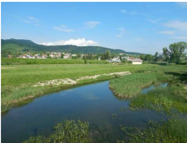
Slika 1c: Zagorska Mrežnica – Obaloutvrde
