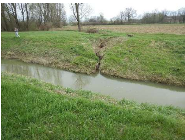
Slika 1c: Crnec – bocni odvodni kanal/pritok
