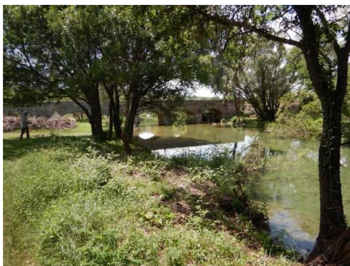
Slika 1c: Zrmanja - most na cesti Kostići-Vukmirice riparijska zona, obala i zaobalje
