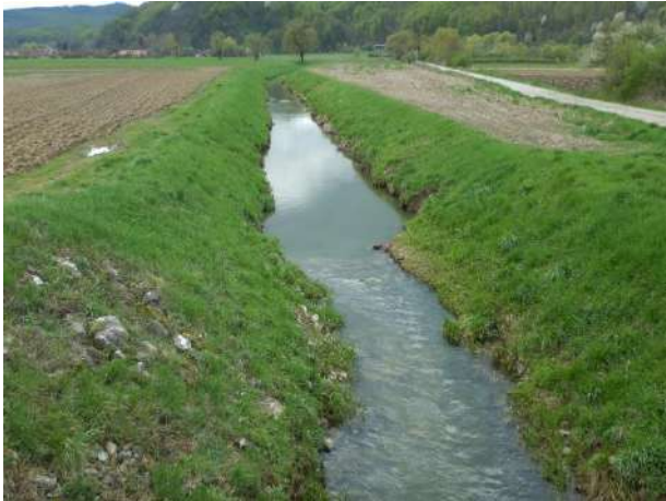
Slika 1a: Bistrica - Podgrađe Bistričko – uzvodno od dionice
