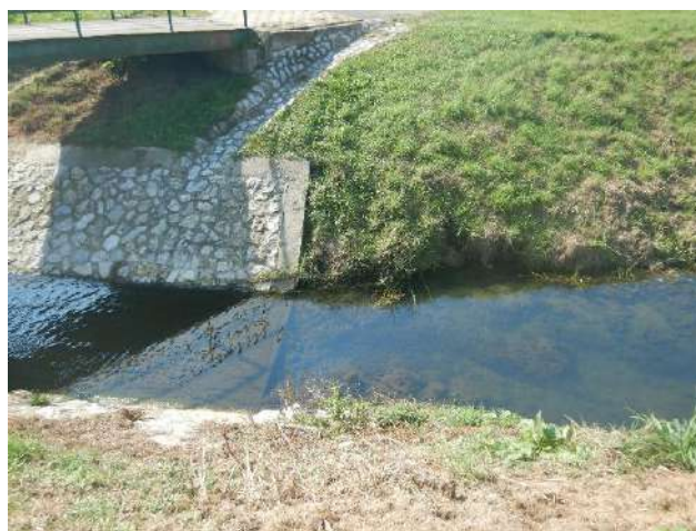
Slika 1d: Brodec – utvrđenost obale i korita ispod mosta
