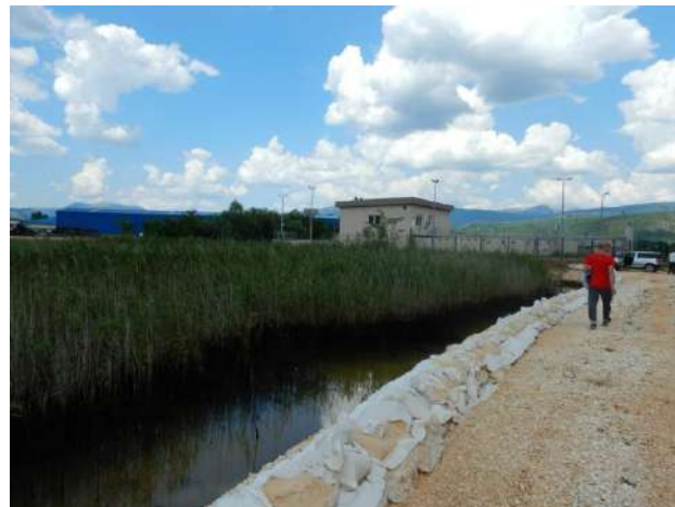
Slika 1b: Vreće pijeska na lokaciji na kojoj je nasip bazena nedavno puknuo
