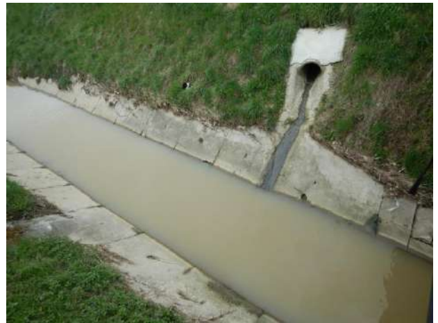
Slika 1b: Kanalizacijski ispust na istraživanom odsječku
