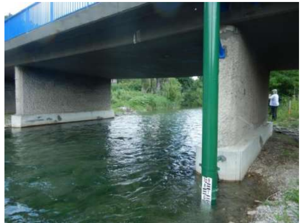
Slika 1d: Na građevini se ne vide tragovi erozije
