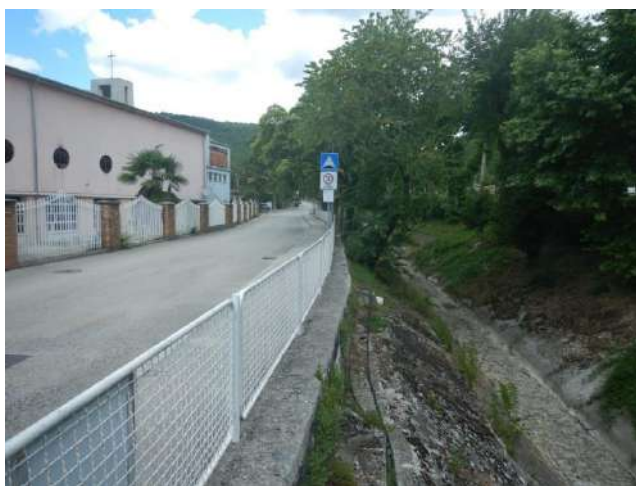
Slika 1c: Dio obale je u potpunosti utvrđen teškim materijalima, a zaobalje privedeno urbano-industrijskoj svrsi
