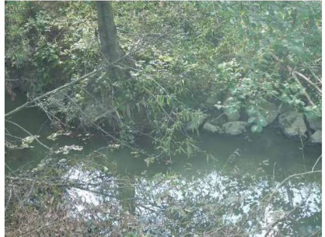
Slika 1b: Gliboki I – utvrđenost obala kamenim nabačajem
