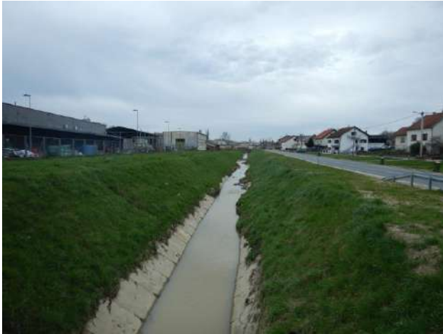
Slika 1a: Pogled na istraživani odsječak uzvodno
