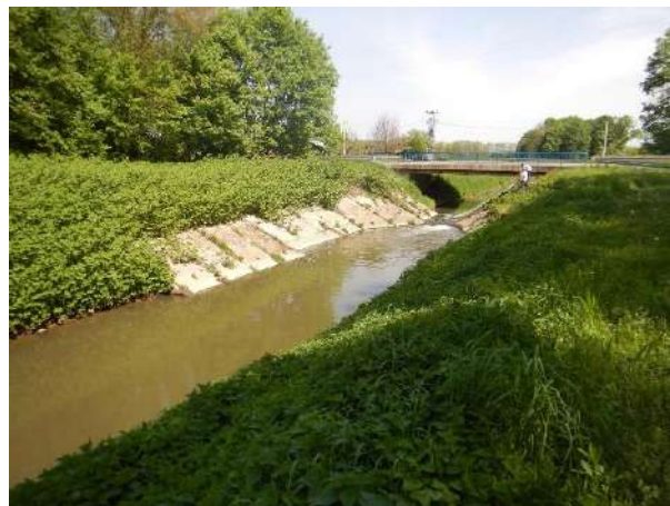
Slika 1b: Bjelovacka – dječlomična utvrđenost obala
