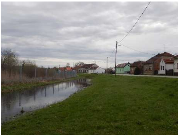
Slika 1c: Ždalica – riparijska zona, obala i zaobalje
