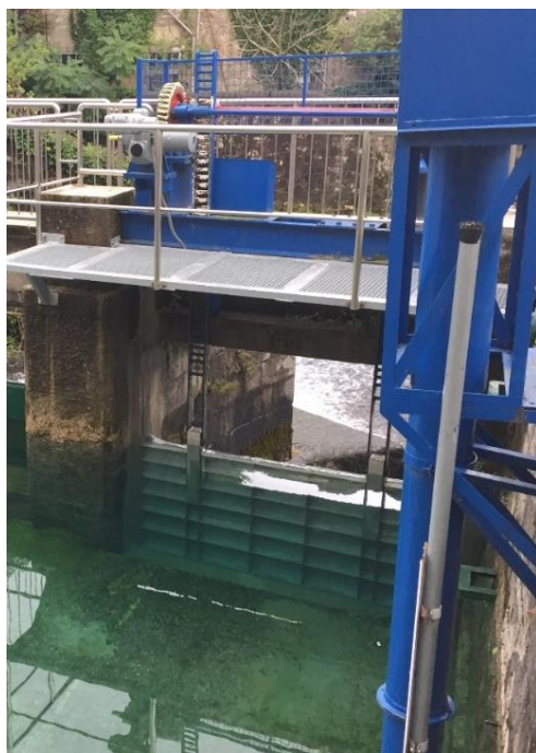
Slika 2.4. Glavna zapornica nakon zamijene te geodetske kote snimljene 9.11.2018. godine
