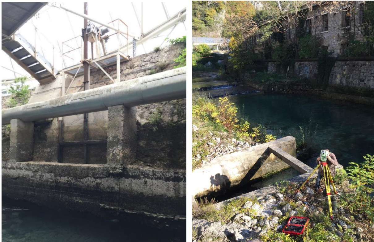
Slika 7.1. Fotografija servisne zapornice na strani bazena (desno) i sa vanjske strane tijekom geodetskog mjerenja (lijevo)
