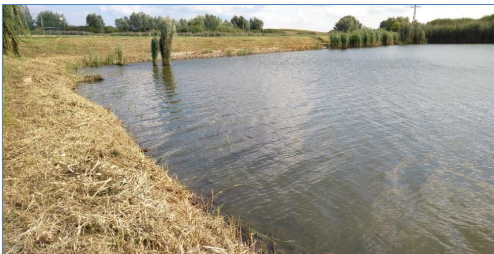
Slika 13.21. Grabovo jezero, obala na sjevernoj obali uz nasip i vidljivi ostaci košenog tršćaka.
