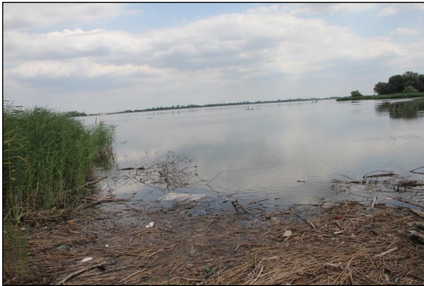
Slika 5.5. Pogled s repnog dijela na akumulacijsko jezero HE Čakovec.
