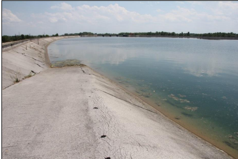
Slika 5.6. Pogled s betonskog nasipa na akumulacijsko jezero HE Dubrava.
