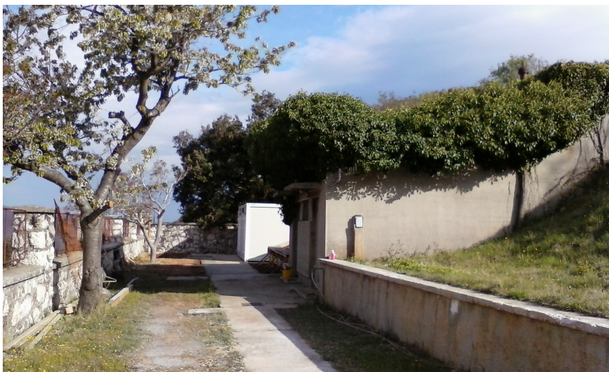
Slika 6.1. Vodosprema Vrana Stara.
