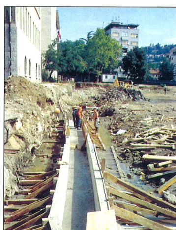
Slika 5.7. Izgradnja novog korita Lešnjaka ispred južnog krila škole Nikola Tesla (Stražićić, 1999.).
