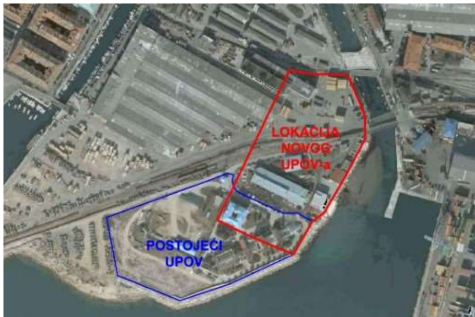
Slika 2.34. Uređaj za pročišćavanje otpadnih voda ( http://www.novolist.hr/ ).
