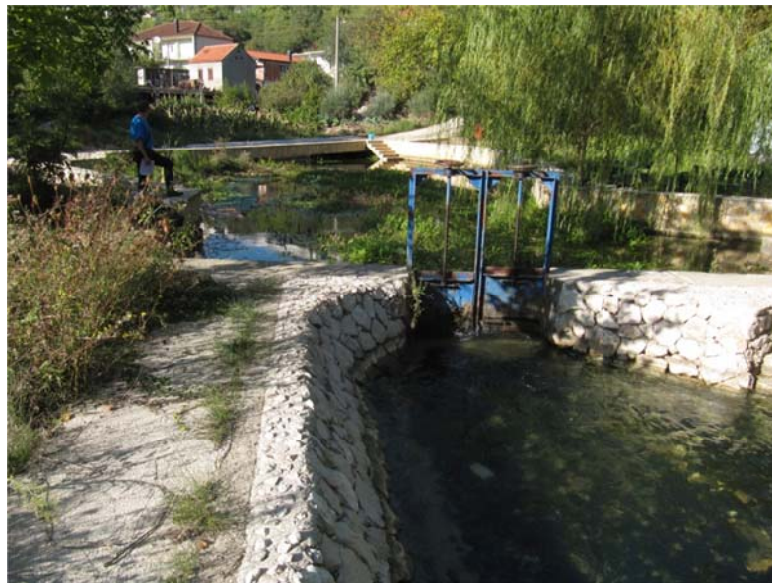
Slika 32. Izvor Lukavac – ustava kojom se regulira otjecanje u minimumu.
