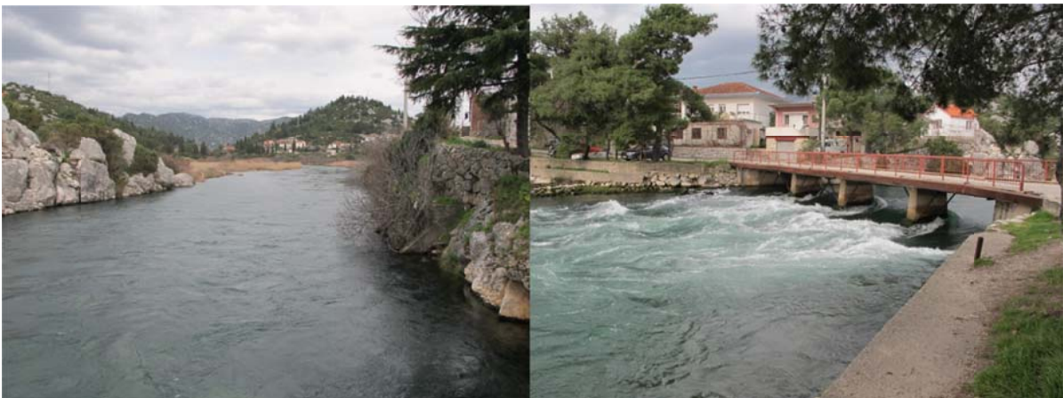
Slika 109. Odvodni kanal a) nizvodno od tunela Baćinska jezera – Bare, b) utok u more u Pločama
