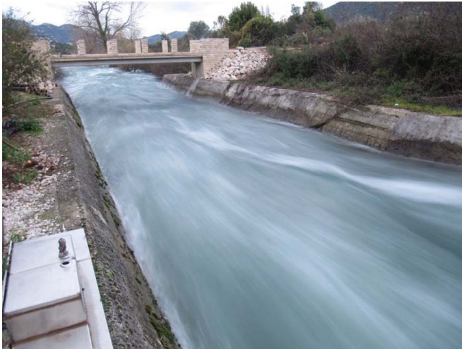
Slika 72. Izlazni kanal iz tunela Vrgoračko polje – Baćinska jezera u uvjetima velikih voda.
