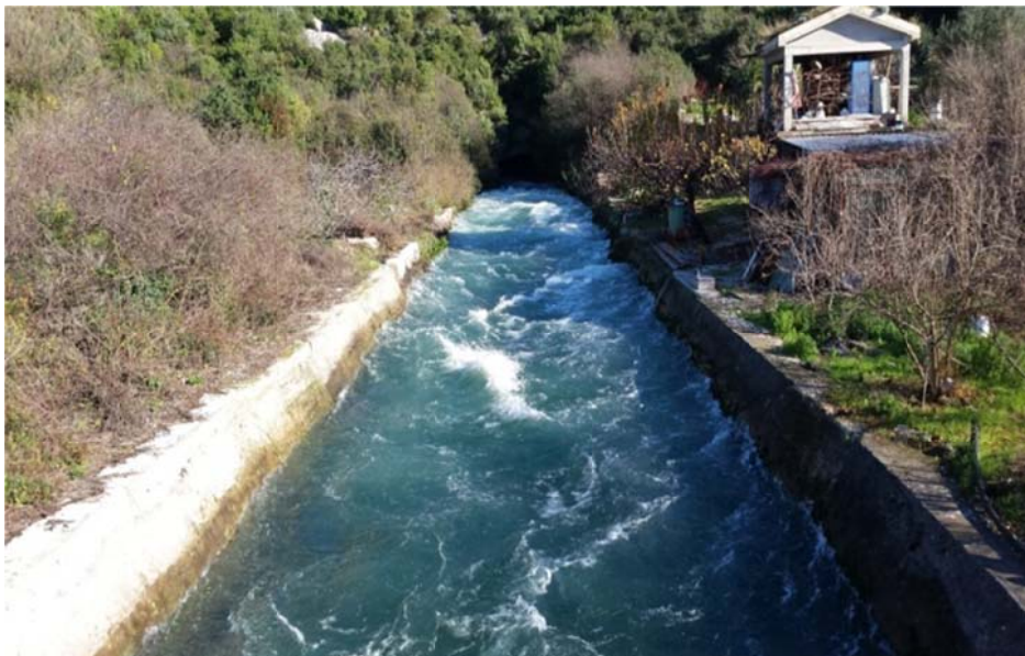
Slika 43. Tunel kojim se dreniraju vode Vrgoračkog polja (Jezero) na ulazu u Baćinska jezera. Različiti hidrološki uvjeti.
