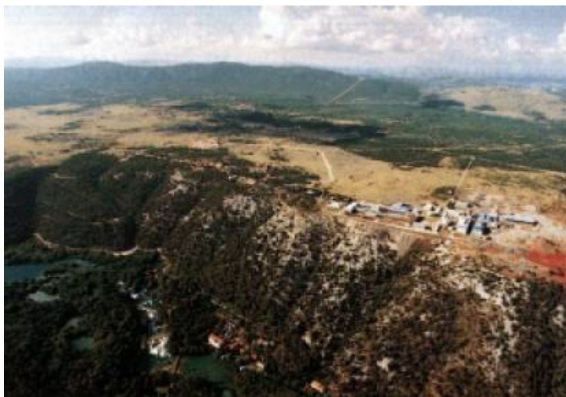
Slika 5.1.2-3: Zračni snimak vodocrpilišta i uređaja za kondicioniranje vode s vodospremom
