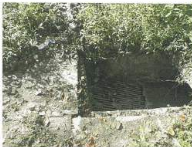
Slika 21: Rešetka na ulazu u primarni taložnik
