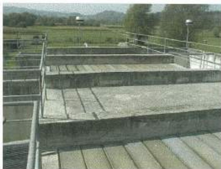
Slika 7: Primarni taložnik pokriven čeličnim talpama
