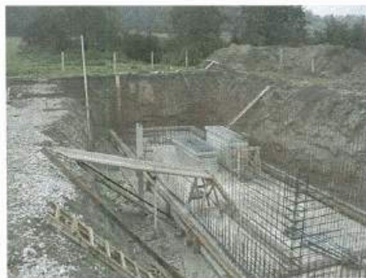
Slika 24: Gradilište novog uređaja u Lobor Gradu
