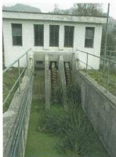
Slika 2: Crpilište i zgrada crpilišta
