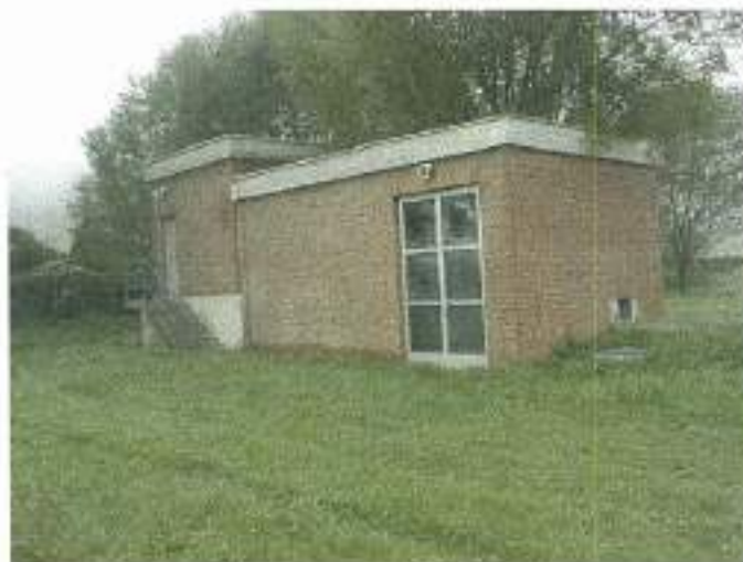
Slika 12: Zgrada crpilišta i rešetke
