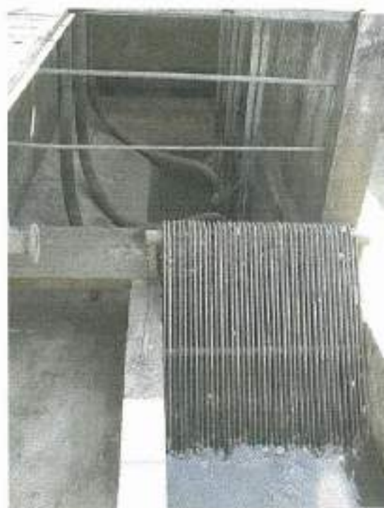
Slika 6: Crpilište s rešetkom
