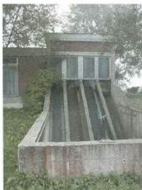
Slika 14: Crpilište s pužnim crpkama
