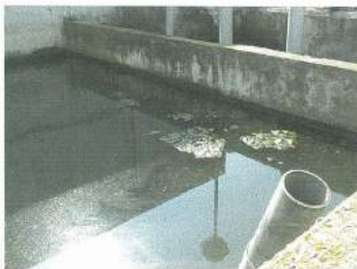
Slika 10: Plivajući mulj u sekundarnom taložniku
