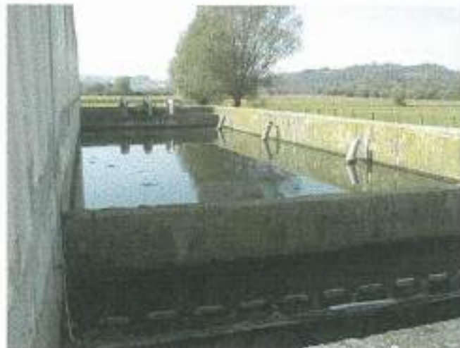
Slika 9: Sekundarni taložnik
