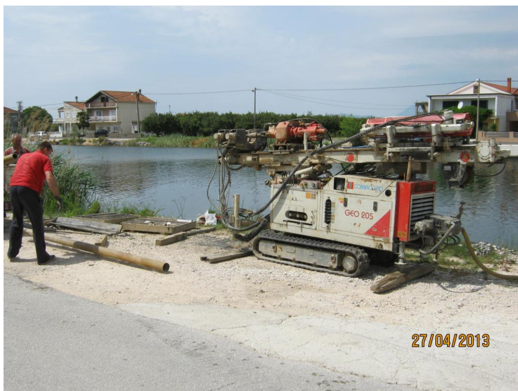
Slika 4. Istražno bušenje - bušotina BM-4
