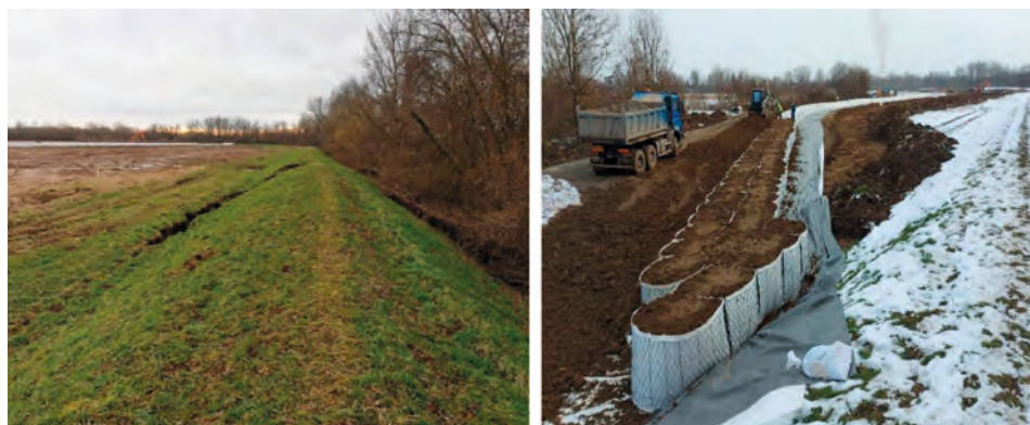
Slika 17. Stara Drenčina - oštećenje nasipa i druga linija obrane od poplava - box barijere
