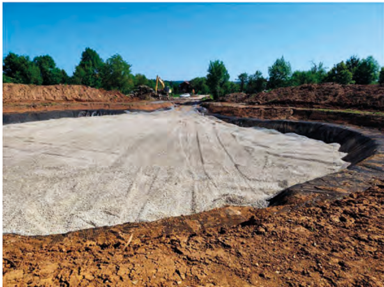
Slika 7. Sanacija vrtače UVM 001, k.o. Mečenčani
