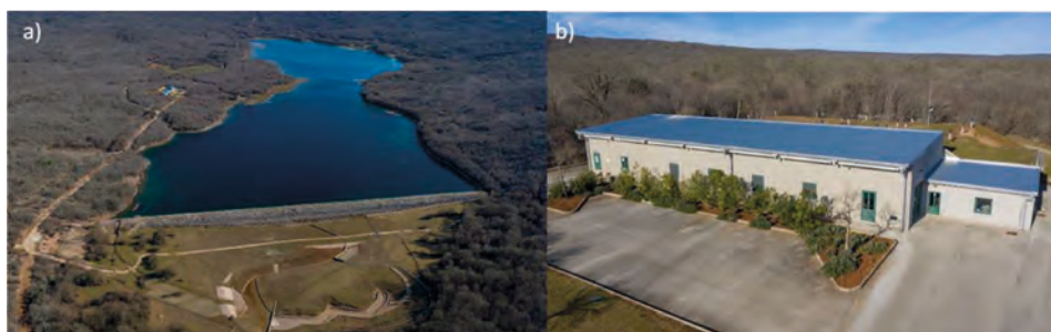
Slika 1a) Akumulacija Ponikve, 1b) Crpna stanica Ponikve (izvor: Ponikve voda d.o.o.)
