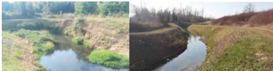
Slika 7. Branjeno područje 14 - lokacija: Vuger - prije i nakon sanacije
