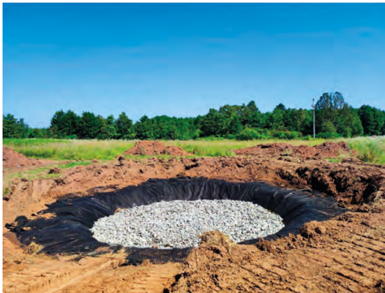
Slika 9. Sanacija vrtače UVM 048, k.o. Mečenčani
