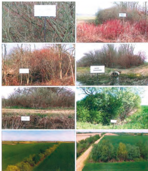
Slika 6. Fotografski prikazi (kao primjer) dokaza stanja neobnovljenih melioracijskih kanala III i/ili IV reda (CRORED-2, 2019.)
