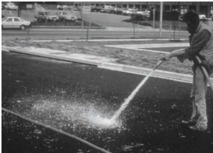
Slika 6. Primjer čišćenja poroznog asfalta (Debo, T. N., 1995)
