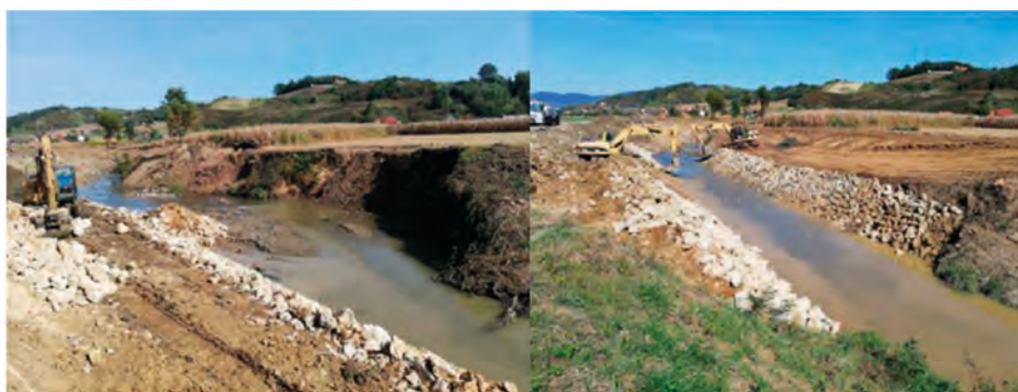
Slika 5. Branjeno područje 12 - lokacija: Krapinica - Dukovec prije i nakon sanacije
