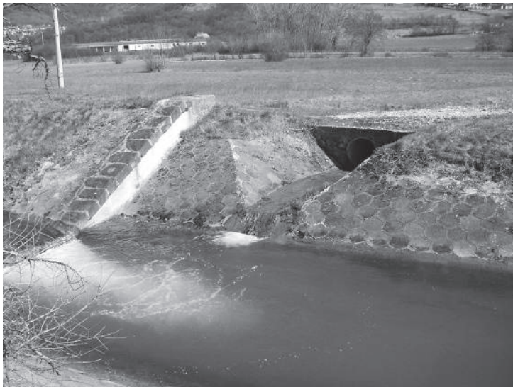
Slika 3: Uređenje potoka Malahuba - stepenica, šesterokutne prizme, uljevna građevina
