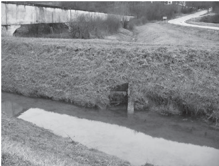
Slika 4: Utok Kanala 1 u Malahubu s uljevnom građevinom
