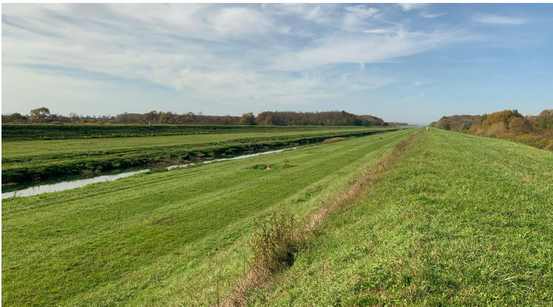
Slika 12. Prikaz lijevog nasipa kanala Kupa-Kupa u 4. km
