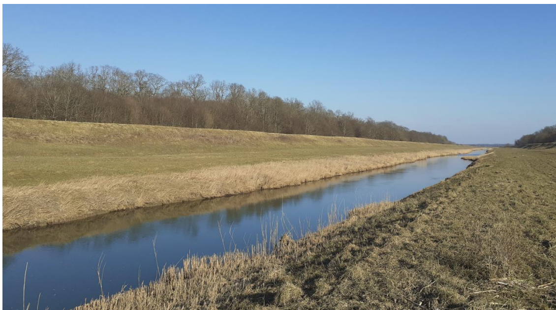
Slika 13. Prikaz lijevog nasipa kanala Kupa-Kupa u 5. km
