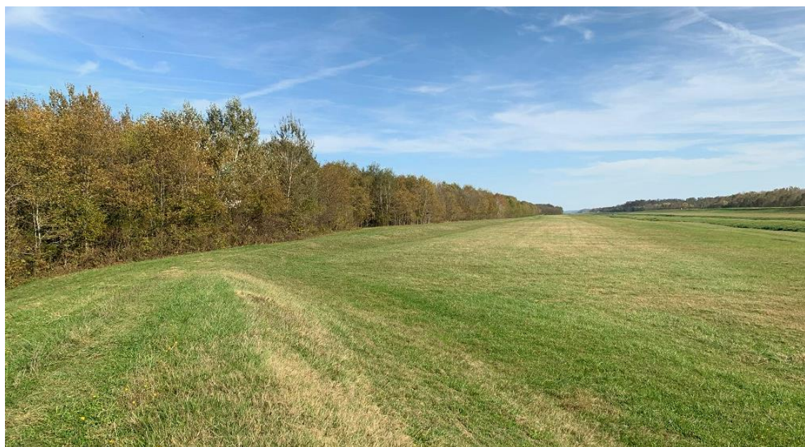
Slika 14. Prikaz lijevog nasipa kanala Kupa-Kupa na području bočnoga preljeva u 6. km
