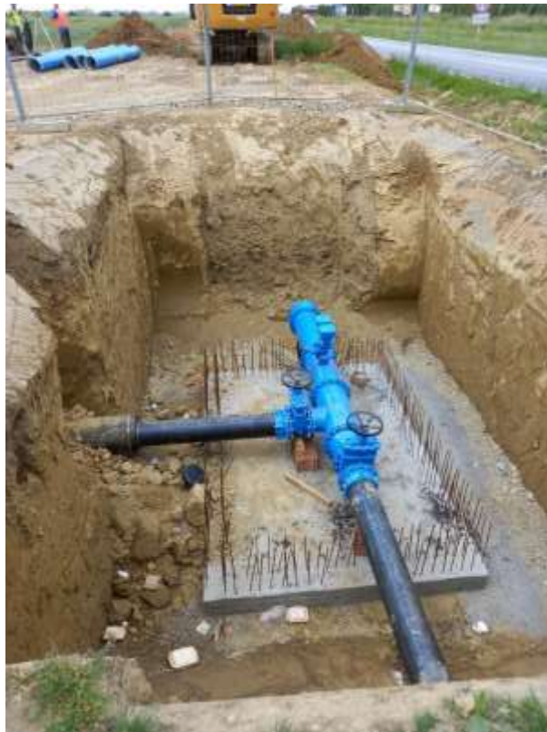
Slika 2-35 Sustavi u izgradnji (SN Gat – II faza – TDM)
